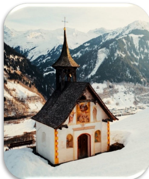
Die Kapelle 2010 neu restauriert und mit Schindeln bedeckt
