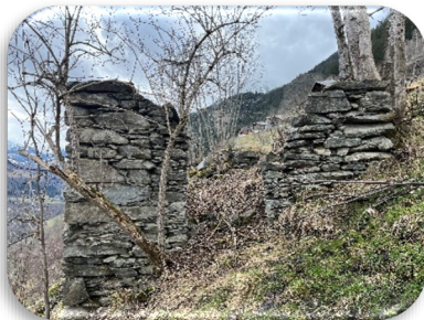
Mauerresten der alten Mühle
