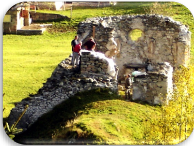
2006 Zerstörte Ruine vor der Resauration.
