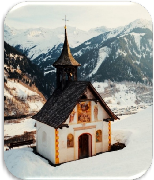
Die Kapelle 2010 neu restauriert und mit Schindeln bedeckt
