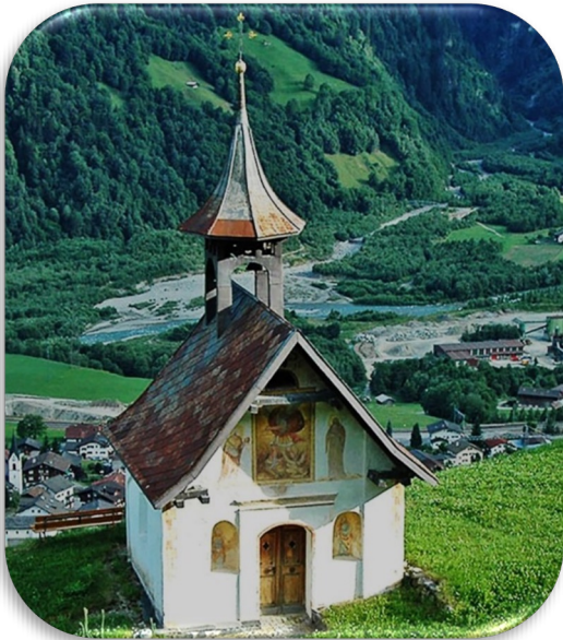
Die Kapelle vor der Sanierung mit Blechdach
