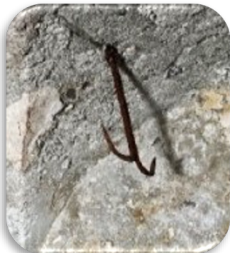
Eisenhaken an der Decke
